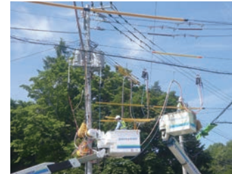
無停電工法による高圧電線張替工事
