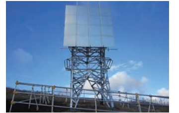
山岳部への電波反射板新設工事
