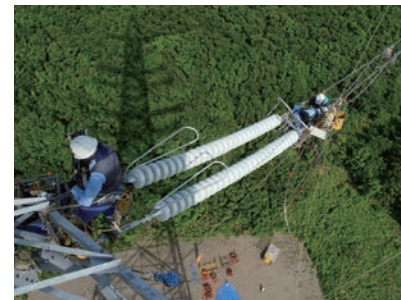
275kV架線工事における緊線作業
