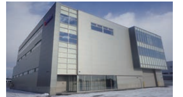
日昭アルミ工業株式会社札幌社屋電気設備工事
